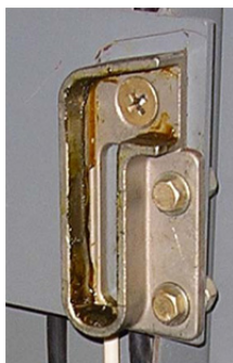
Рис.4.8. Упор шкафа К-37
