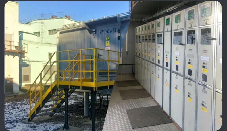
СТЕКОЛЬНЫЙ ЗАВОД | УДМУРТИЯ
