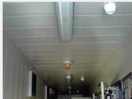
Рис. 54 Основное и аварийное освещение
