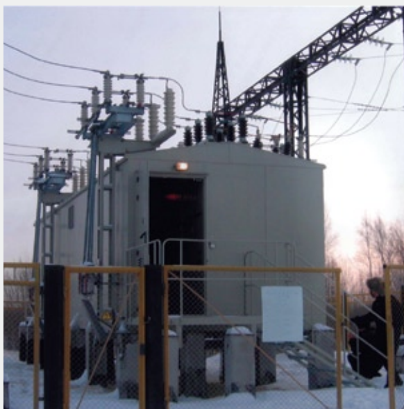
Рис. 19. Установка модуля на сваи
