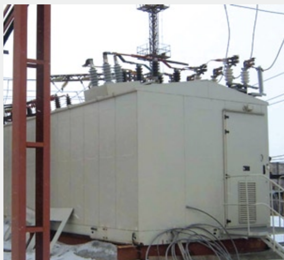
Рис. 20. Установка модуля на низкий фундамент
