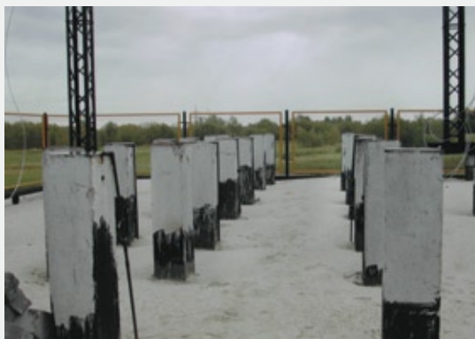
Рис. 7. Подготовка свайного фундамента для КРУМ
