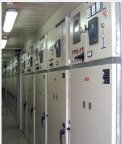
Рис. 25 Комплектное распределительное устройство серии D-40P
