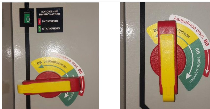
А) выключатель отключен и заблокирован
