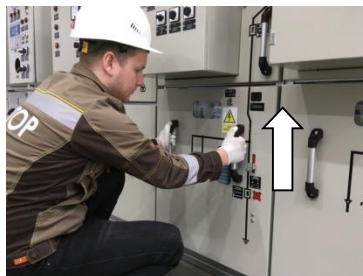
Рис. 2.11 Организация доступа в отсек присоединений
