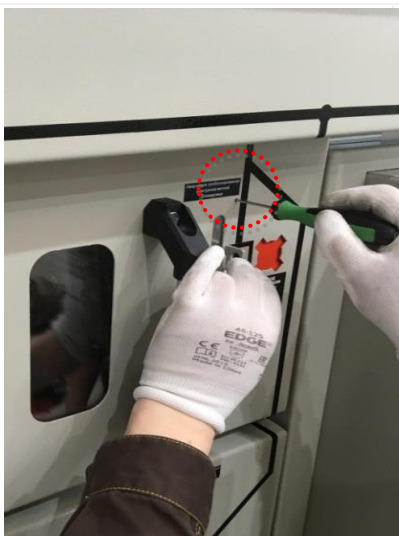
Рис. 2.38 Деактивация блокировки
