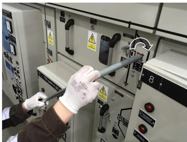
Рис. 2.14 Поворот рычага переключения
