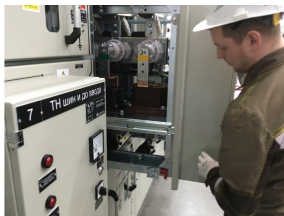
Рис. 2.23 Перемещение моноблока в положение технического обслуживания
