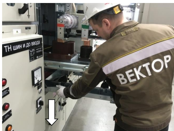
Рис. 2.23 Перемещение моноблока в положение технического обслуживания
