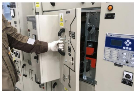
Рис. 2.21 Доступ в отсек ТН
