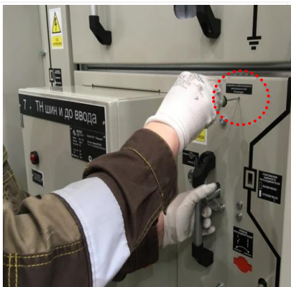
Рис. 2.41 Деактивация блокировки
