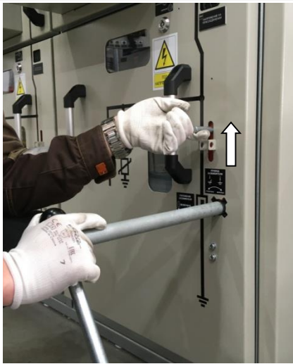
Рис. 2.7 Перемещение ручки заслонки вверх и размещение рычага переключения заземлителя
