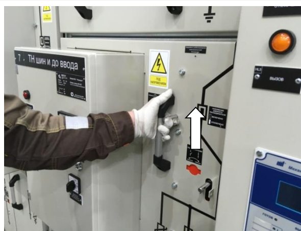
Рис. 2.20 Открытие двери отсека ТН
