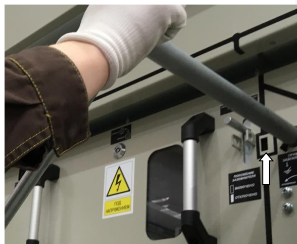
Рис. 2.15 Индикация положения заземлителя
