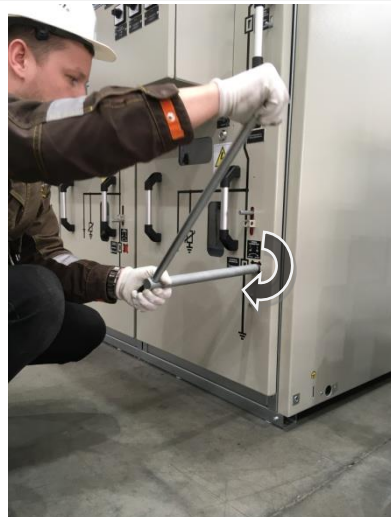
Рис. 2.8 Включение заземлителя
