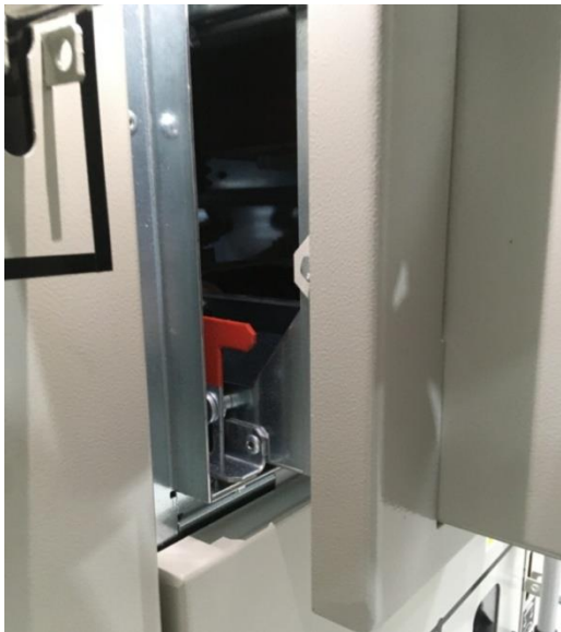
Рис.2.24 Контрольное положение моноблока
