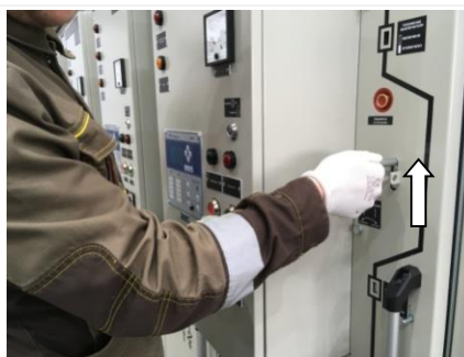
Рис. 2.33 Перемещение ручки заслонки вверх
