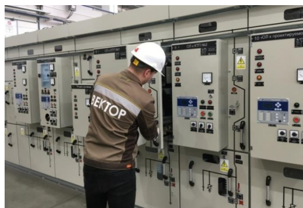
Рис. 2.22 Перемещение моноблока в положение технического обслуживания
