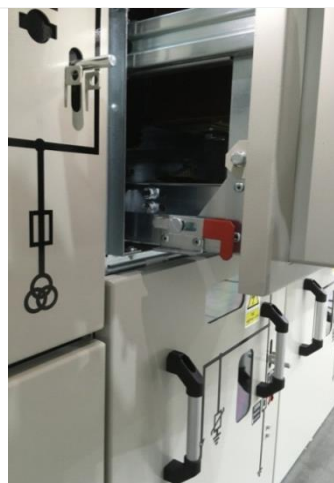
Рис.1.4 Разрешено перемещение моноблока в рабочее положение
