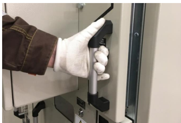
Рис. 2.22 Перемещение моноблока в положение технического обслуживания
