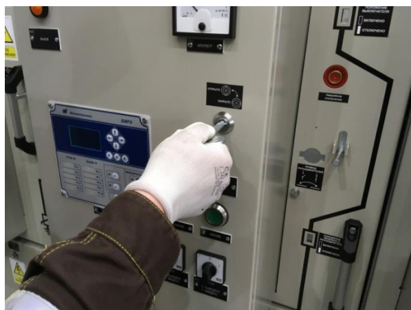
Рис. 2.28 Порядок организации доступа в отсек РЗиА
