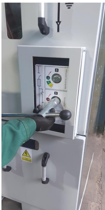
Рис. 2.29 Отключение заземлителя
