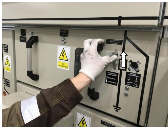
Рис. 2.12 Перемещение ручки заслонки вверх
