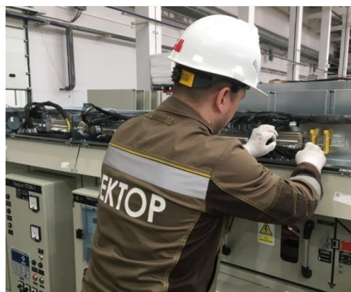
Рис.1.8 Прокладка транзитных цепей
