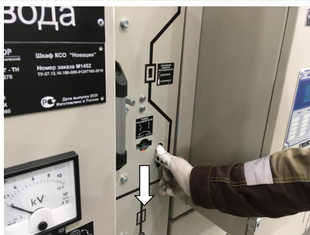
Рис. 2.17 Перемещение ручки заслонки
