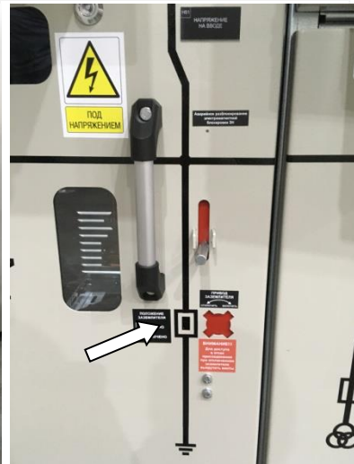
Рис. 2.9 Индикация положения разъединителя
