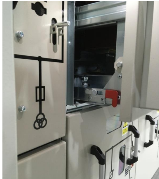
Рис.2.25 Разрешено перемещение моноблока в рабочее положение
