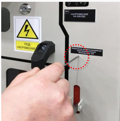
Рис. 2.35 Деактивация блокировки
