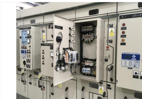
Рис.1.7 Релейный отсек
