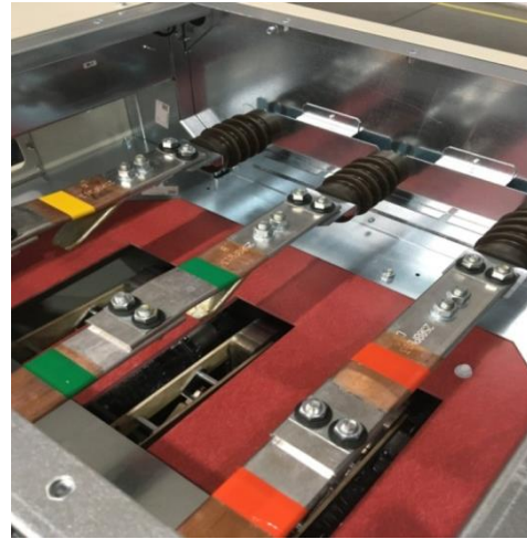
Рис. 2.2 Последовательность монтажа сборных шин секции
