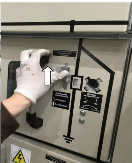
Рис. 2.39 Перемещение ручки заслонки вверх
