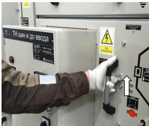
Рис. 2.42 Открытие двери отсека ТН
