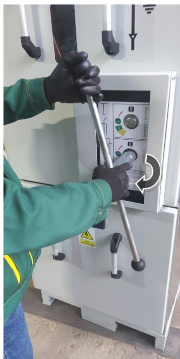
Рис. 2.29 Отключение заземлителя
