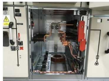
Рис. 2.11 Организация доступа в отсек присоединений
