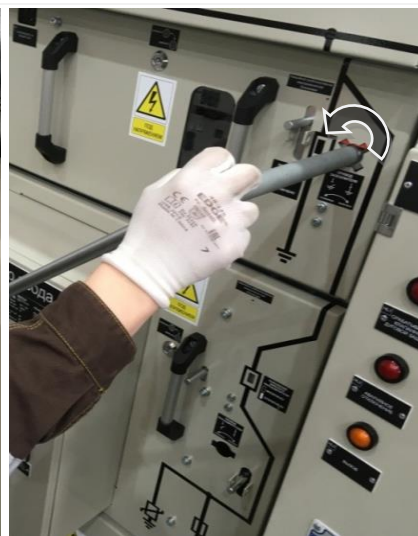
Рис. 2.40 Поворот рычага переключения
