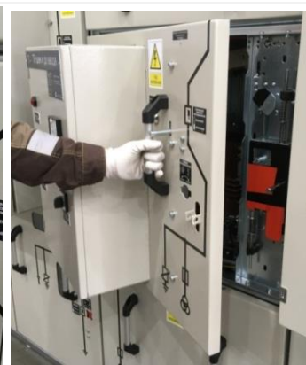
Рис. 2.42 Открытие двери отсека ТН
