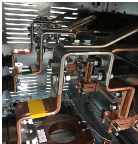
Рис.1.6 Отсек присоединений
