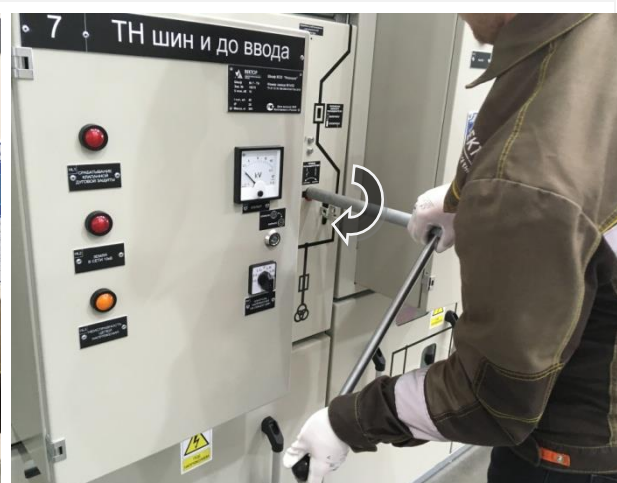
Рис. 2.18 Поворот рычага переключения
