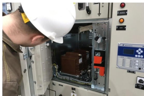
Рис. 2.21 Доступ в отсек ТН
