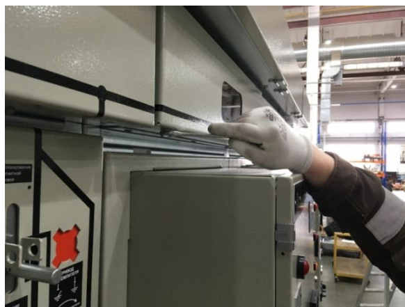
Рис. 2.26 Крышка отсека сборных шин
