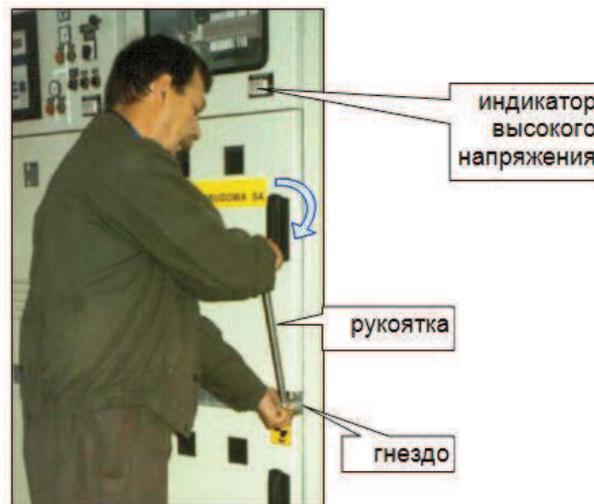
3. строго в вертикальном положении вынуть рукоятку из гнезда привода.
