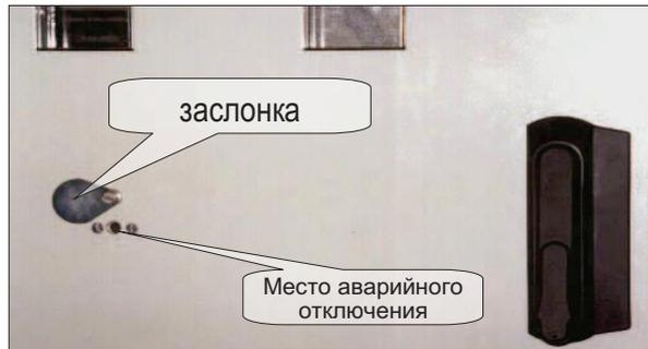
Для аварийного отключения выключателя следует:
