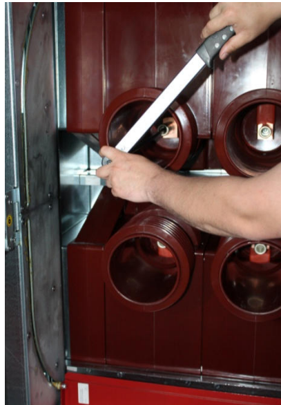
Рис. 3.12 Демонтаж шин
