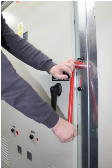
Рис. 2.8 Размещение рычага оперирования заземлителем
