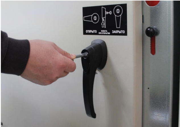
Шаг 1: Вложить ключ в личинку замка ручки и повернуть его по часовой стрелке
