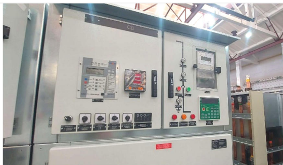
Рис.1.8 Фасад отсека вспомогательных цепей
