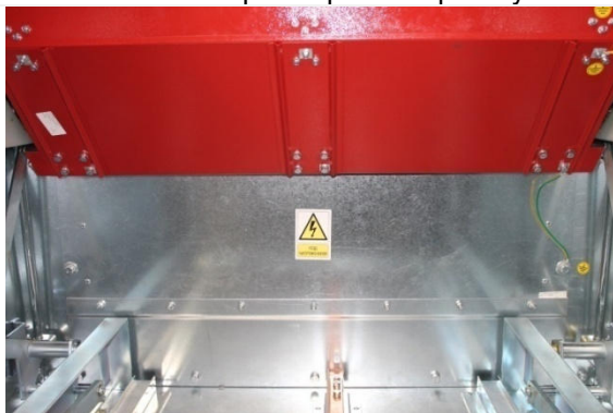
Рис.3.5 Организация доступа в отсек сборных шин с НССШ
