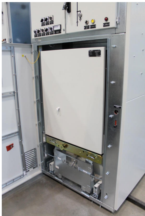
Рис.1.16 ВЭ в контрольном положении (вид при открытой двери)
