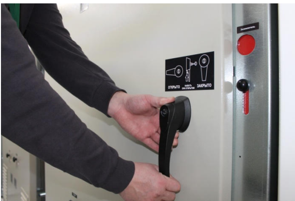
Шаг 3: Удерживая рукой проушину для навесного замка, повернуть ручку на 90° по часовой стрелке
