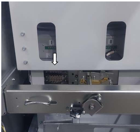
Рис. 1.22 Концевые выключатели на ВЭ
