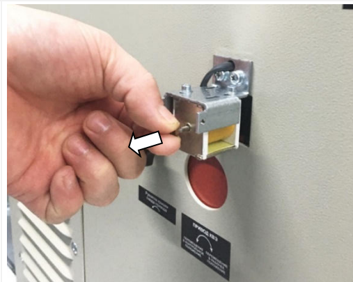
Рис. 2.25 Перемещение сердечника
