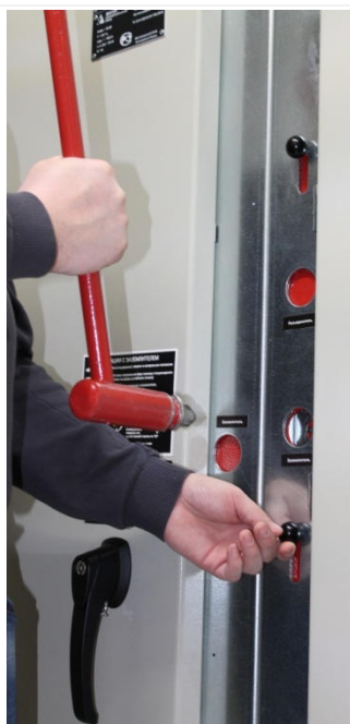
Рис. 2.15 Включение заземлителя СШ
