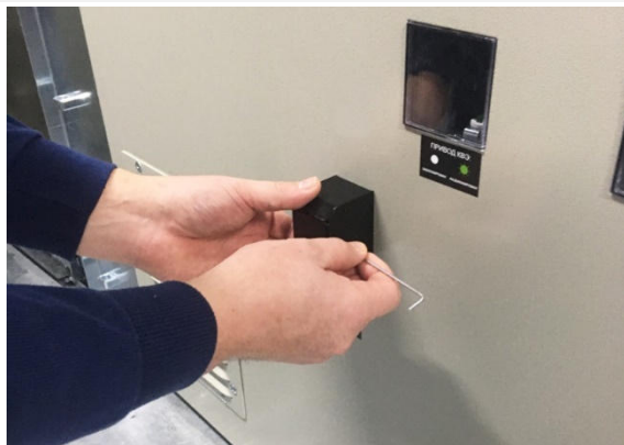
Рис. 2.24 Демонтаж крышки электромагнита
