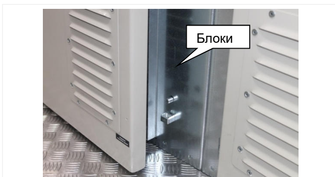
Рис. 1.30 Работа блокировки ВЭ
