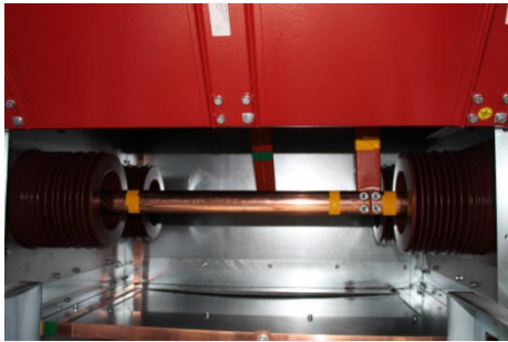
Рис. 1.3 Отсек сборных шин НССШ (вид при извлеченном ВЭ и снятой перегородки)
