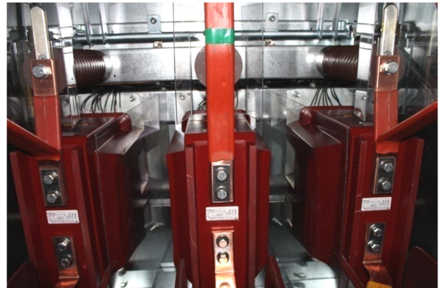
Рис. 3.11 Вид после демонтажа ревизионных панелей
