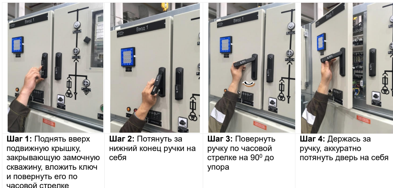
Рис. 2.2 Последовательность действий при открытии дверей отсека вспомогательных цепей
