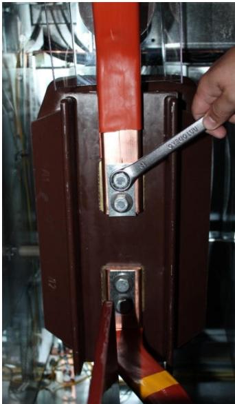
Рис. 3.10 Снятие верхней шторки
