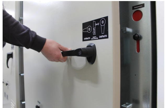
Шаг 3: Удерживая рукой проушину для навесного замка, повернуть ручку на 90° по часовой стрелке
