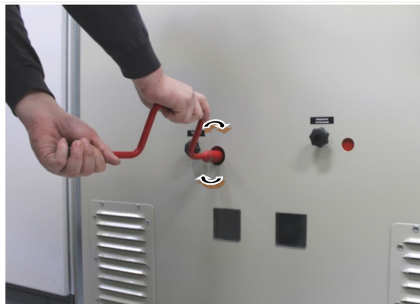
Рис. 2.5 Вращение винтовой передачи ВЭ
