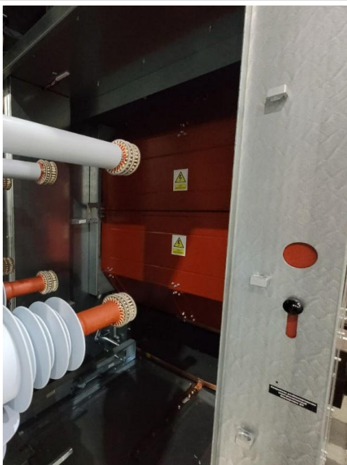
Рис. 1.28 Отсек ВЭ при закрытых шторках
