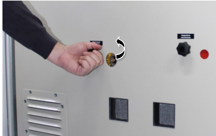
Рис. 2.4 Доступ к гнезду оперирования ВЭ
