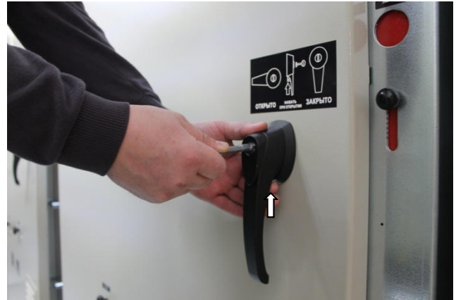
Шаг 2: Проушину для навесного замка на ручке сдвинуть вверх
