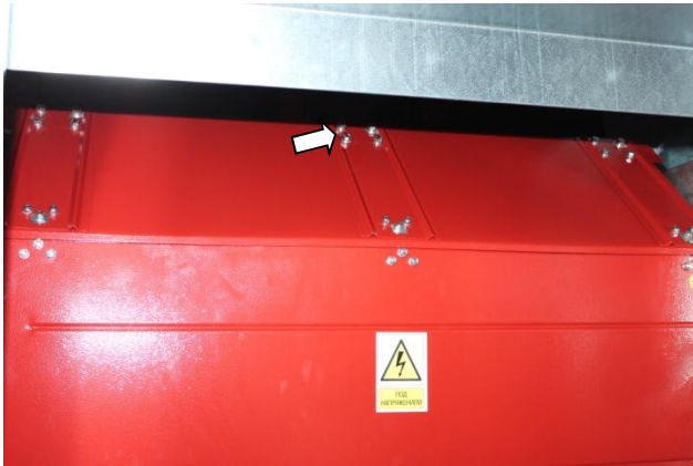
Рис. 3.10 Снятие верхней шторки
