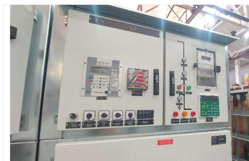
Рис. 2.10 Фасад отсека вспомогательных цепей с органами местного управления
