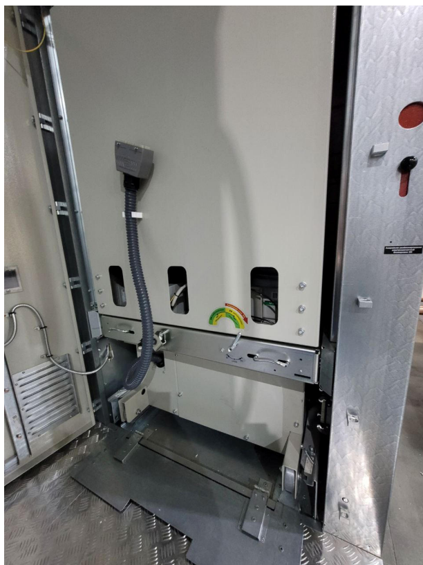
Рис. 2.17 Отключения разъема вспомогательных цепей ВЭ
