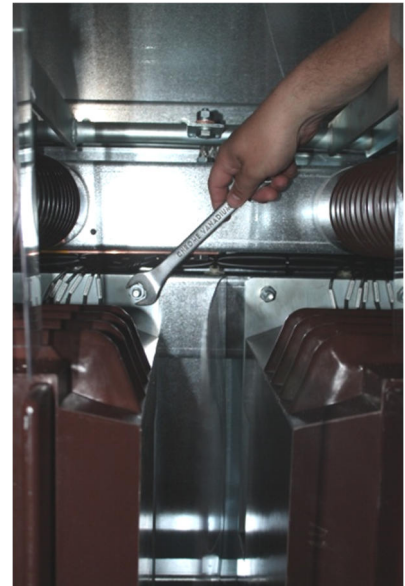
Рис. 3.13 Демонтаж ТТ
