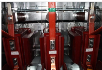
Рис. 6 Отсек присоединений НССШ
