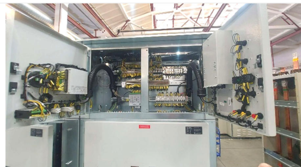
Рис. 9 Отсек вспомогательных цепей (вид при открытой двери)
