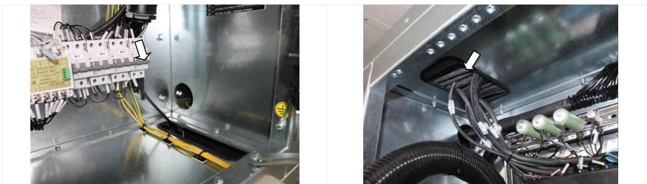
Рис. 10 Отверстия для прокладки межсекционных связей
