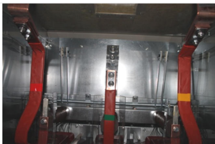
Рис. 6 Отсек присоединений НССШ
