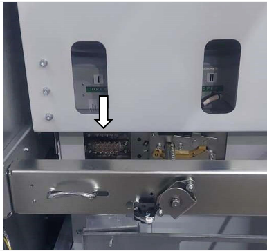
Рис. 14 Концевые выключатели на ВЭ
