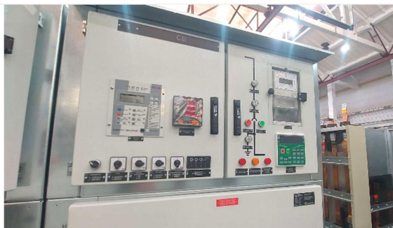
Рис. 8 Фасад отсека вспомогательных цепей
