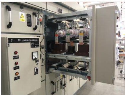
Рис.3 Положение технического обслуживания моноблока
