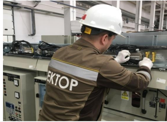
Рис. 6 Прокладка транзитных цепей
