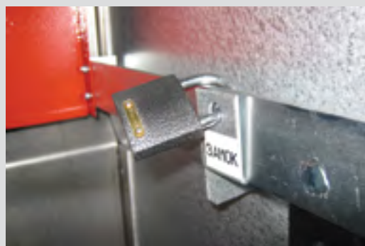
Рис. 6.8. Блокирование шторочного механизма
