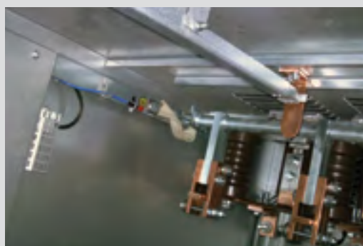
Рис. 10.4. Оптический датчик в зоне присоединений
