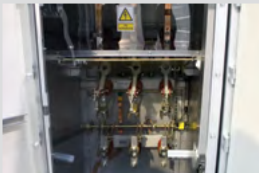
Рис. 6.13. Подвижная изоляционная плита
