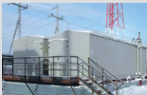
Рис. 12.3. Параллельная компоновка КРУМ
