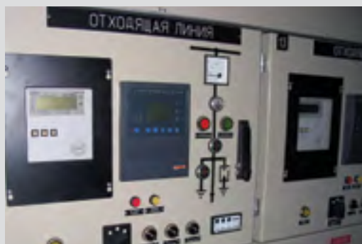
Рис. 8.2. Шкаф КРУ с МПЗ типа Seram
