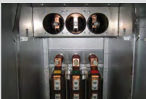
Рис. 6.6. Ответные контакты главной цепи шкафа
