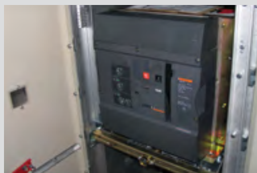
Рис. 6.10. КВЭ на базе выключателя Evolis
