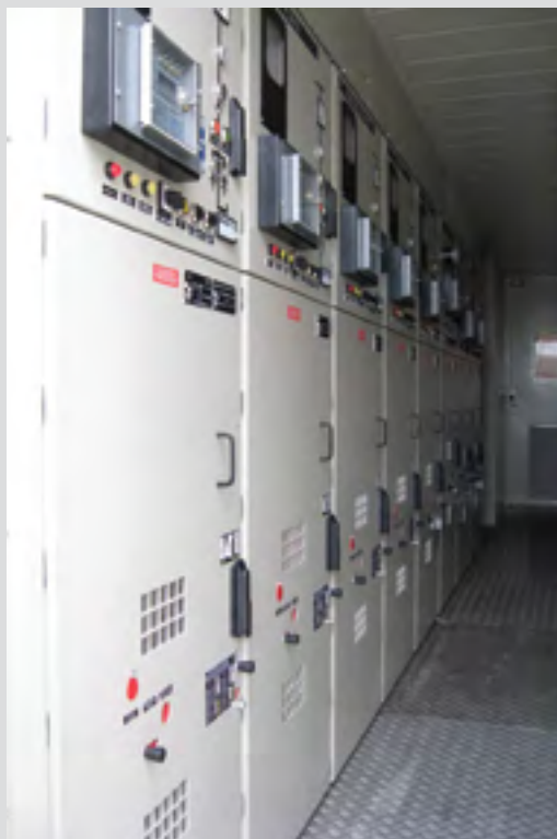
Рис. 11.2. Однорядное расположение шкафов КРУ
