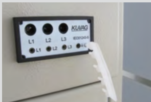
Рис. 9.2. Индикатор наличия напряжения
