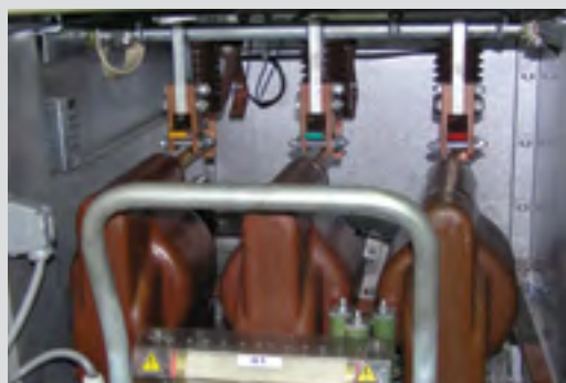
Рис. 6.17. Измерительные ТН до ввода
