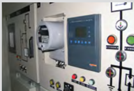
Рис. 9.3. Мнемосхема главной цепи шкафа КРУ
