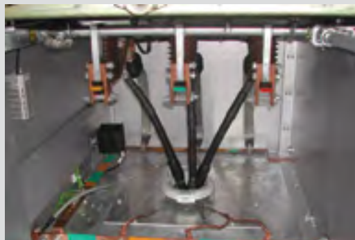
Рис. 6.16. Подключение кабельной линии
