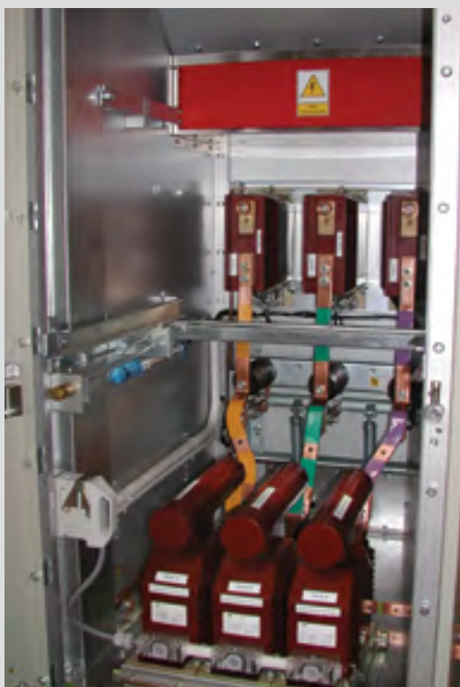
Рис. 6.5. Совмещенный высоковольтный отсек
