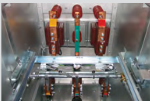
Рис. 6.7. Зона выдвижного элемента
