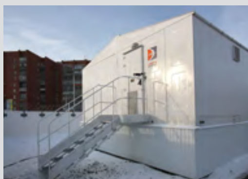
Рис. 12.4. Двухмодульная совмещенная компоновка КРУМ
