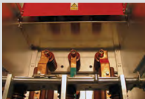
Рис. 9.1. Сегрегация отсеков в шкафу КРУ D-12PT
