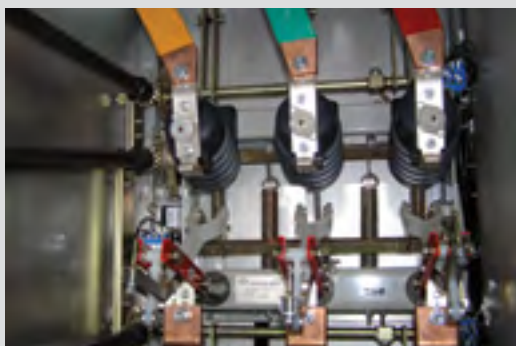
Рис. 6.12. Автогазовый выключатель нагрузки
