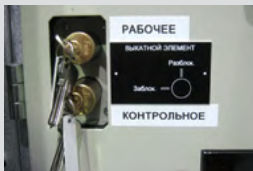
Рис. 9.5. Замковая блокировка КВЭ
