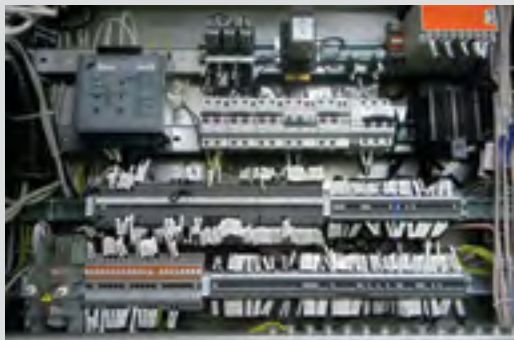
Рис. 10.5. Индивидуальная оптоволоконная ДЗ шкафа
