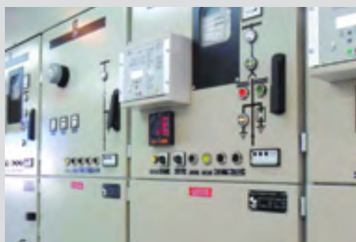
Рис. 8.3. Шкафы КРУ с МПЗ серии БЭ2502 (ЭКРА)
