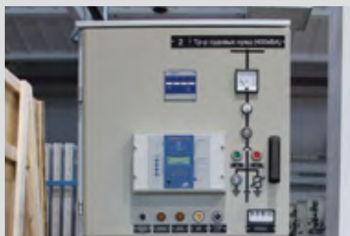
Рис. 8.4. Шкафы КРУ с МПЗ типа Сириус-2
