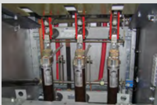
Рис. 6.14. Шкаф ТШН с ВН и предохранителями
