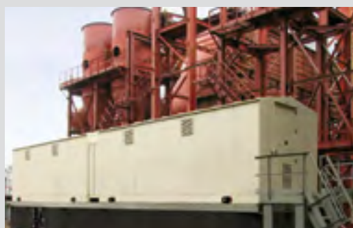
Рис. 12.2. Линейная компоновка КРУМ
