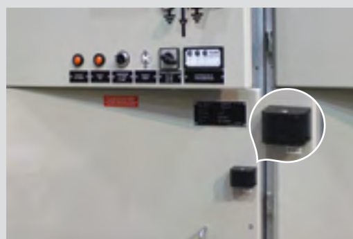
Рис. 9.8. Электромагнитная блокировка заземлителя
