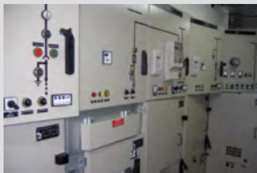
Рис. 8.1. Шкаф КРУ с МПЗ типа УЗА
