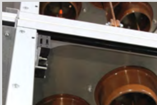
Рис. 10.1. Концевой выключатель
