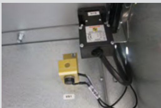
Рис. 10.8. Двухступенчатая дуговая защита
