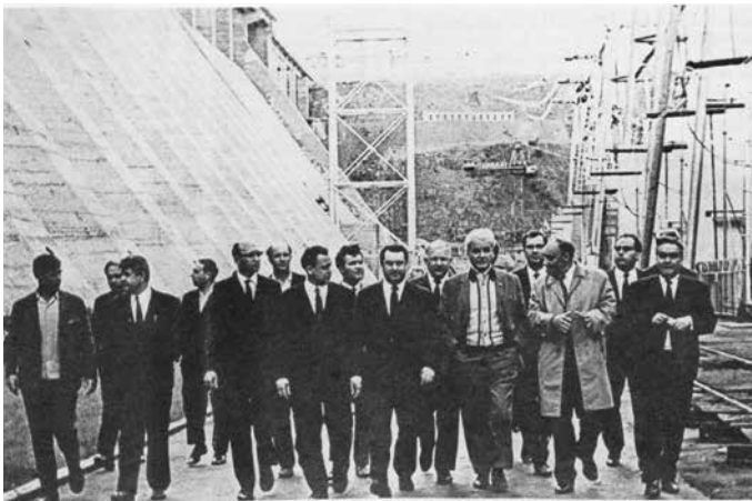
На строительстве Братской ГЭС
