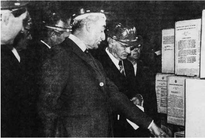
П. С. Непорожний на Литовской ГРЭС
