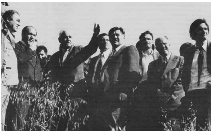
П. С. Непорожний ставит задачи участникам коллегии по строительству Березовской ГРЭС-1
