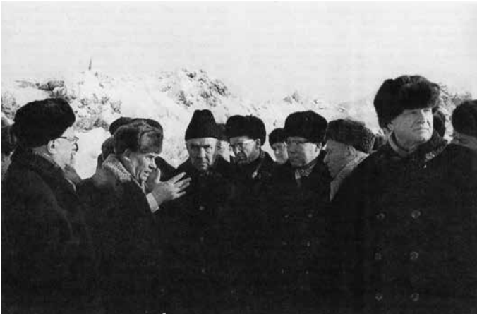
Заместитель директора объединения «Якуталмаз», директор рудника «Айхал» П. С. Новоселецкий рассказывает А. Н. Косыгину и сопровождающим его лицам о ходе строительства горно-обогатительного комбината, сооружаемого Минэнерго СССР
