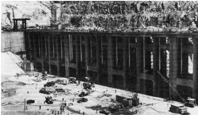
Строительство плотины на Ниле
