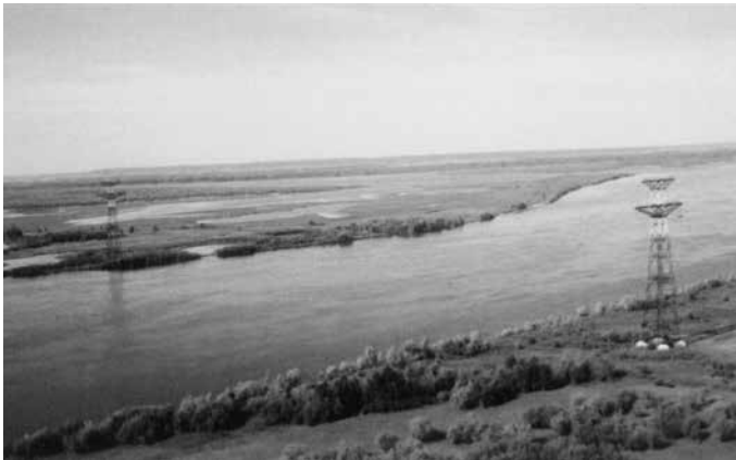
Переход ВЛ 500 кВ через Обь
