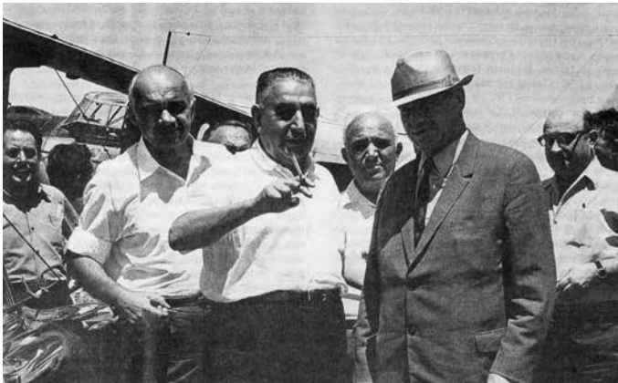
На строительстве Аракской ГЭС
