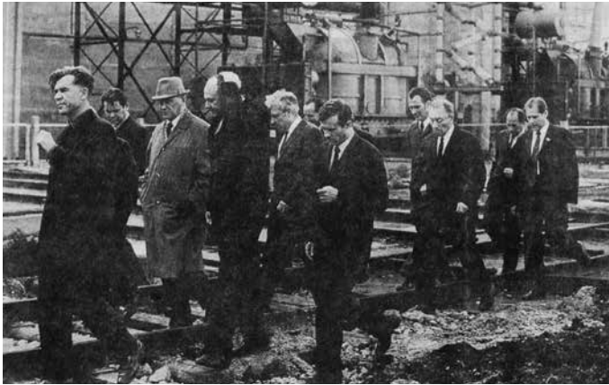
Заинская ГРЭС им. 50-летия СССР. П. С. Непорожний осматривает станцию
