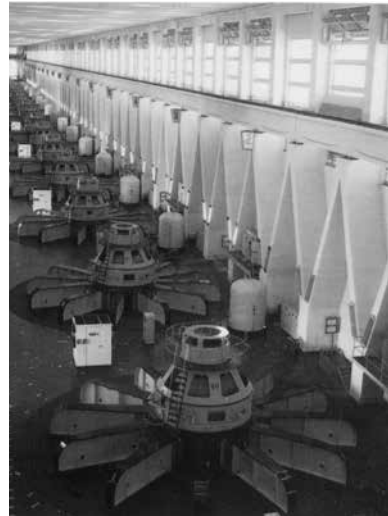
Машинный зал Братской ГЭС
