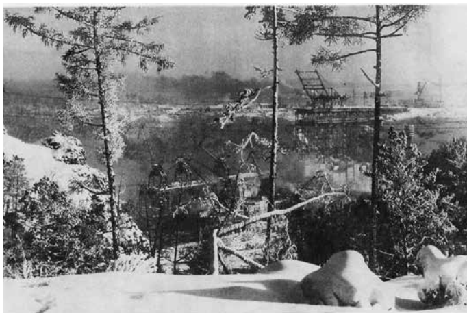
Начало строительства Усть-Илимской ГЭС
