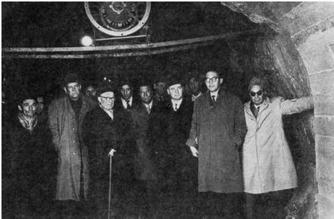
Руководство строительства на стройплощадке ГЭС «Наглу»
