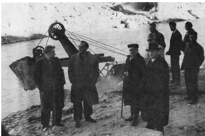
На стройке гидроузла «Наглу»
