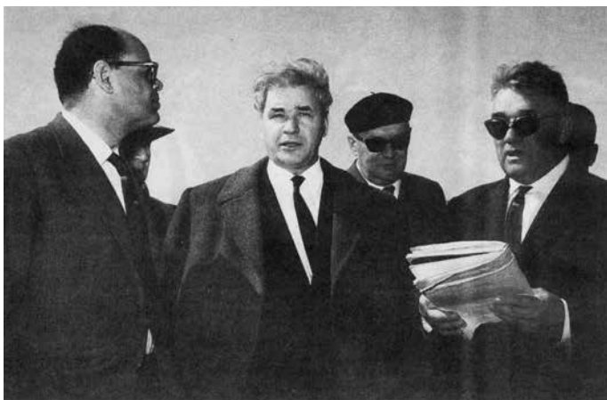
На строительстве Высотной Асуанской плотины. Министр энергетики ОАР г-н Ситке-Сулейман, министр энергетики и электрификации СССР П. С. Непорожний, главный эксперт А. П. Александров (слева направо)
