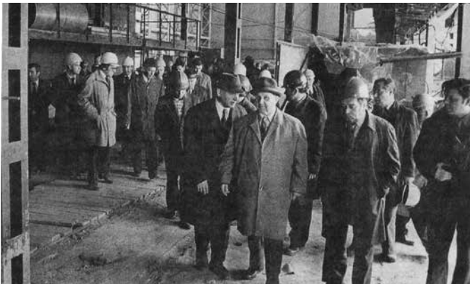
Надеждинская строительная площадка. У министра Минэнерго СССР П. С. Непорожного (первый слева) немало вопросов к министру Минмонтажспецстроя Н. В. Бакину (второй слева)
