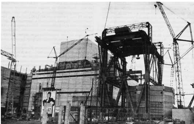
Смоленская АЭС. Главный корпус
