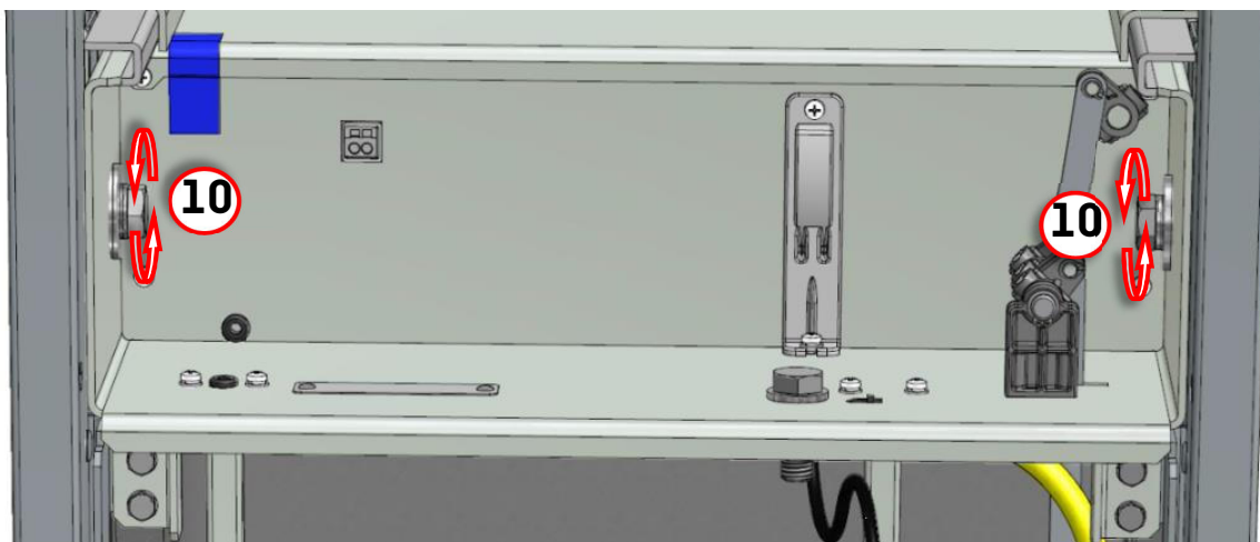
Рис.8.5. Демонтаж дополнительных болтов крепления MB в шкафах TER_SP15_Etalon_2
