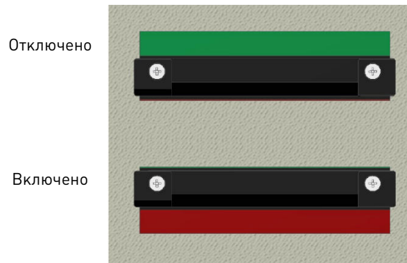
Рис.4.3. Встроенные указатели положения главных контактов
