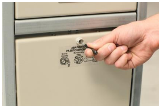
Рис.6.43. Ручное разблокирование замка и снятие двери кабельного отсека
