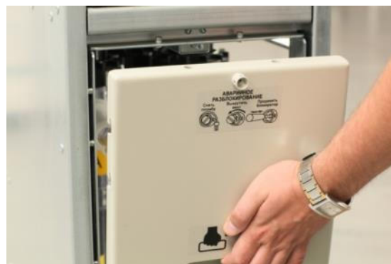
Рис.6.43. Ручное разблокирование замка и снятие двери кабельного отсека
