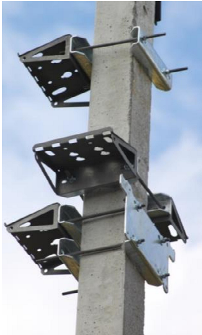
Рис. 4.19. Монтаж кронштейнов для трансформаторов тока
