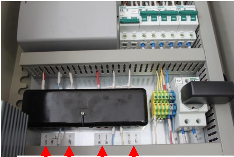
Цепи подключения измерительных каналов для схемы 2ТНх2ТТ
