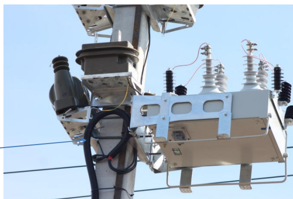
Рис. 4.39. Выполнение «гусака» на гофротрубе
