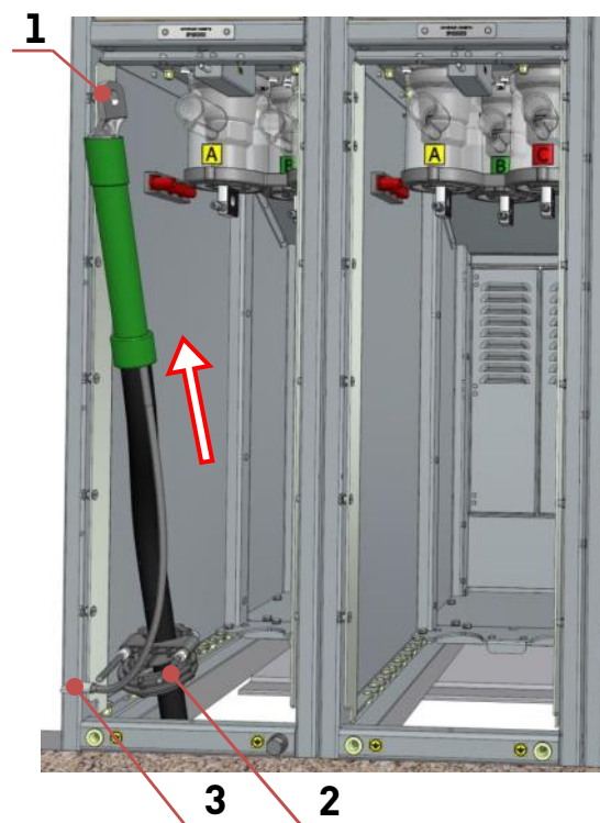
Рис.6.11. Подготовка одножильного кабеля к монтажу
