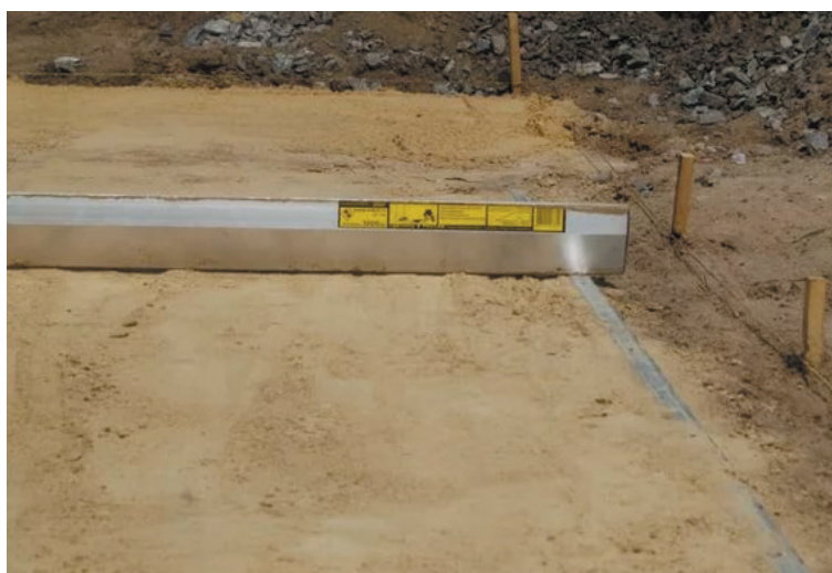
Рис. 4.1 Результат вертикальной планировки площадки под строительство подстанции
