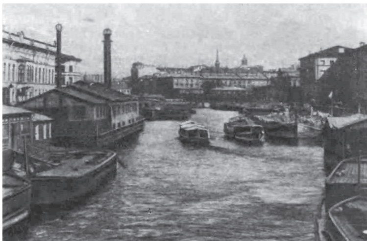
Рис. 6—25 Электростанция на р. Фонтанке в Петербурге.
