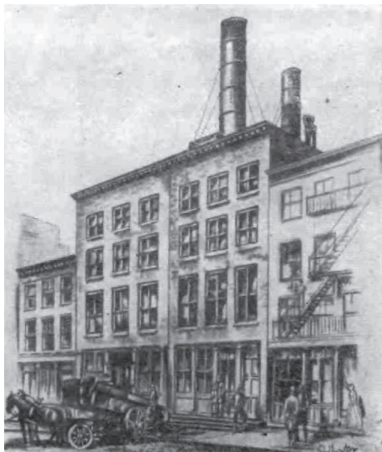
Рис. 6–22 Внешний вид первой центральной электростанции.
